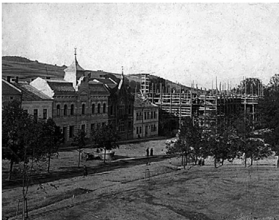
Kościół parafialny w Grybowie w trakcie budowy. Zdjęcie wykonane ok. 1914 r. przez R. Olszewskiego.
