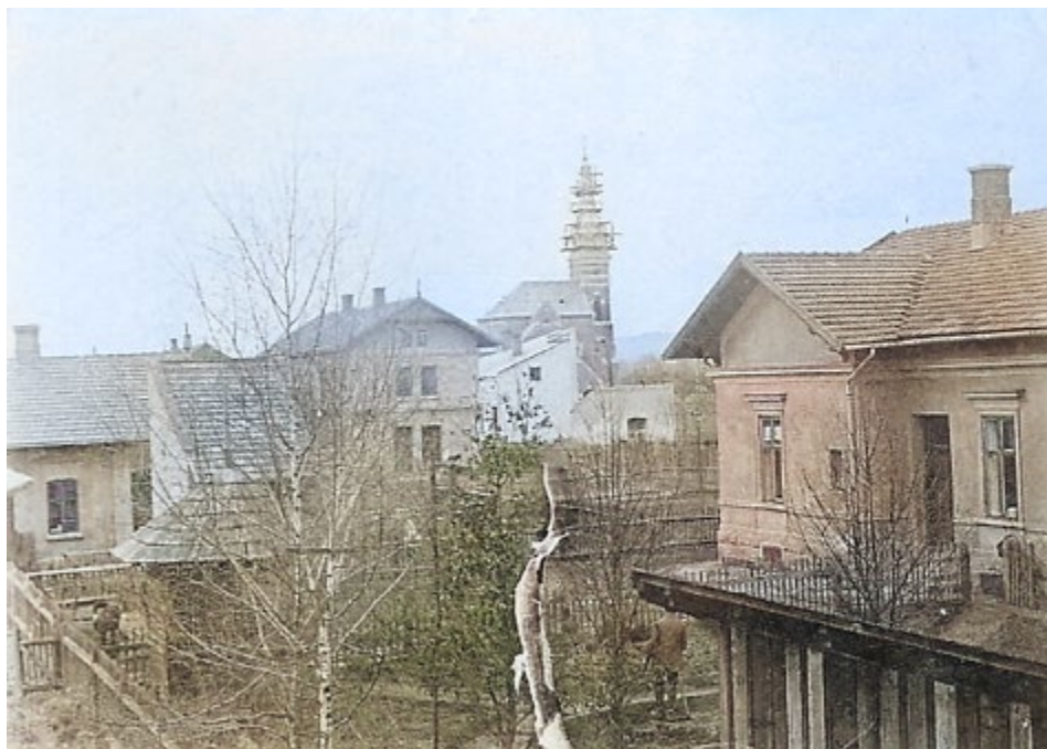
Widok na będącą w budowie kaplicę, ponad dachami domów Kolonii Robotniczej w Nowym Sączu z ok. 1898 r. Budynek z prawej to jeszcze w tym czasie parterowy (obecnie piętrowy) dom lk. 797 przy Gasse I (Ulicy I, ob. 1 Maja) nie należący do zabudowy Kolonii Robotniczej, z lewej lk. 805 przy ulicy Quergasse II (Poprzeczna II; ob. Zamoyskiego). Fot: udostępnione dzięki uprzejmości Andrzeja Kubika, z archiwum rodzinnego
