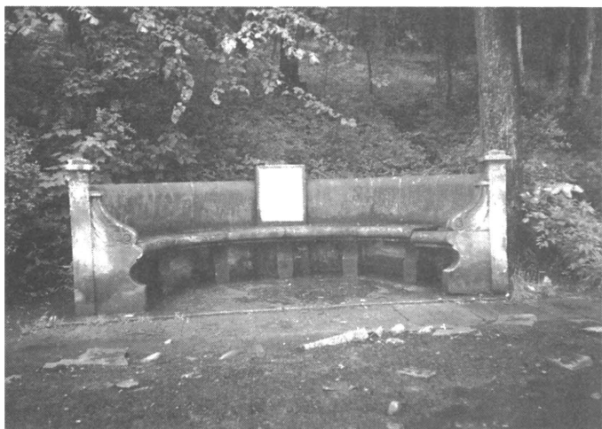
Zakątek Kraszewskiego przed remontem....
