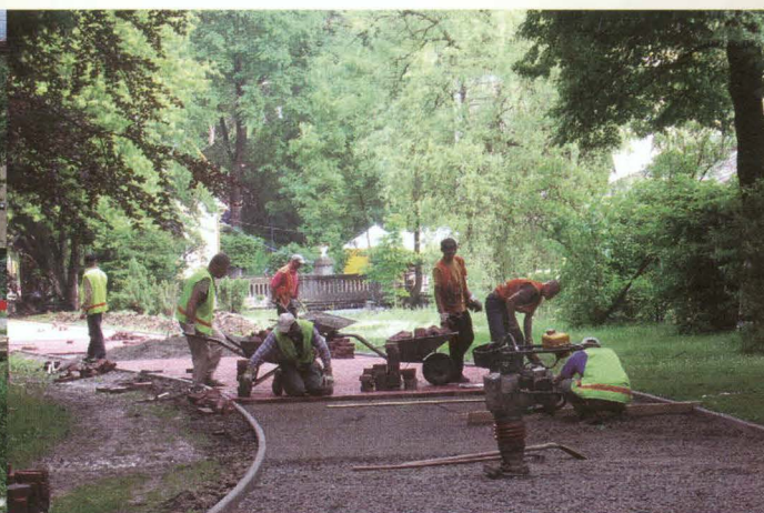
Trwają prace przy remoncie chodnika na skwerku łączącym ulicę Ebersa z deptakiem.
