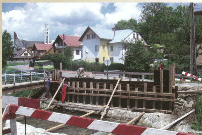
Od końca maja trwa przebudowa mostu na ul. Granicznej. W związku z tym ten odcinek drogi został wyłączony z ruchu samochodów, natomiast piesi mogą przedostać się na drugą stronę przechodząc przez kładkę. Na czas remontu drogi dojazd do ulicy Granicznej i Żródlanej został wytyczony przez ulicę Słoneczną. Jak informuje Urząd Miejski w Krynicy-Zdroju przebudowa mostu potrwa do końca lipca.
