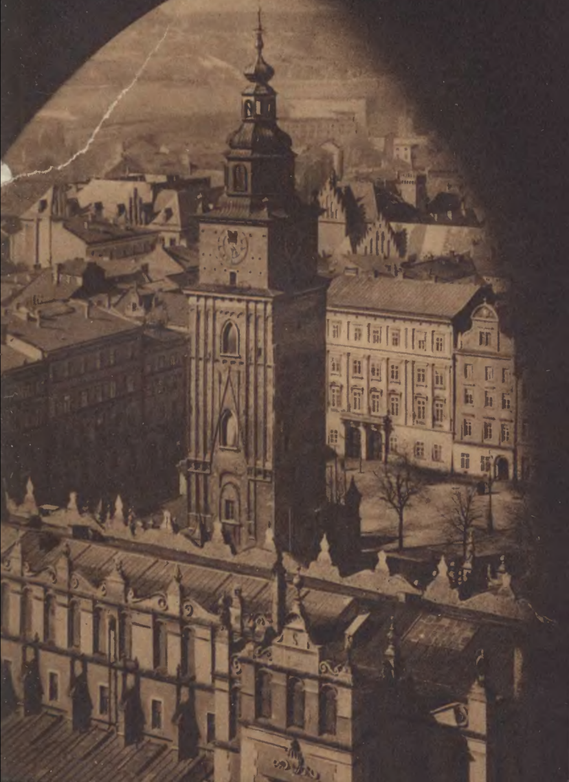
Kraków — Widok z wieży Marjackiej
