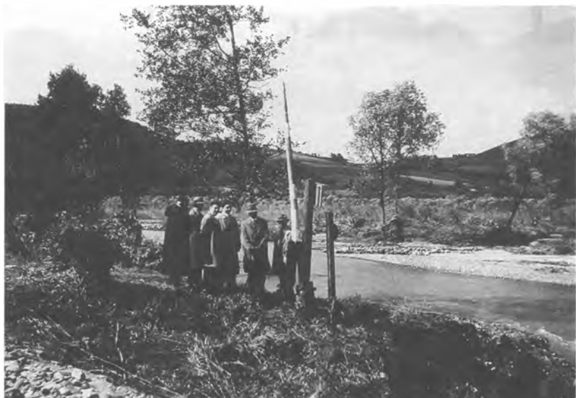
Lipiec 1934 r. Linia kolejowa Nowy Sącz–Chabówka. Ze strzeżonego przejazdu kolejowego pozostała jedynie rogatek.
