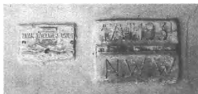
7 XI 1993. Marcinkowice. Znak wielkiej wody na ścianie domku dróżnika w km 69.0 linii kolejowej Nowy Sącz – Chabówka. Fot. Leszek Zakrzewski
