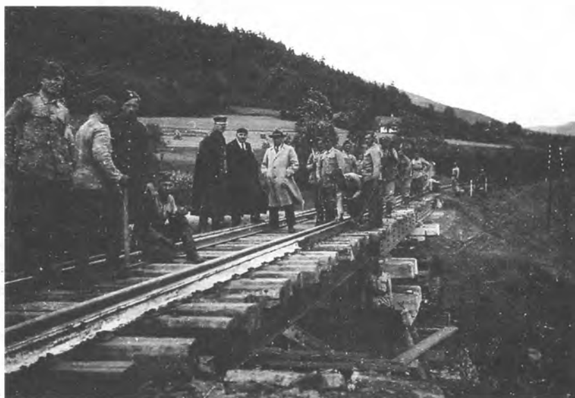
Lipiec 1934 r. Na linii Nowy Sącz–Chabówka. Junacy odbudowują most kolejowy. Fot. ze zbioru Ryszarda Krzeszowskiego
