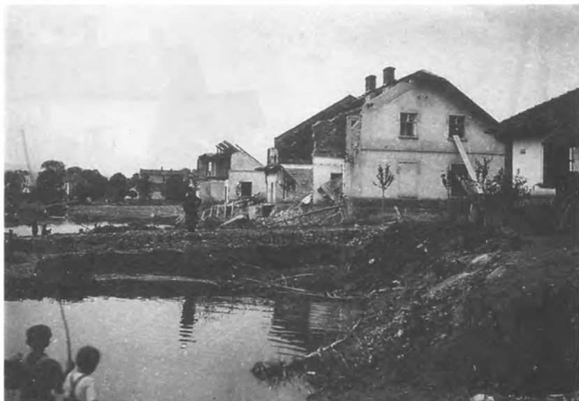
Lipiec 1934 r. Nowy Sącz. Ruiny domów nad Kamienicą. Fot. ze zbioru Ryszarda Krzeszowskiego
