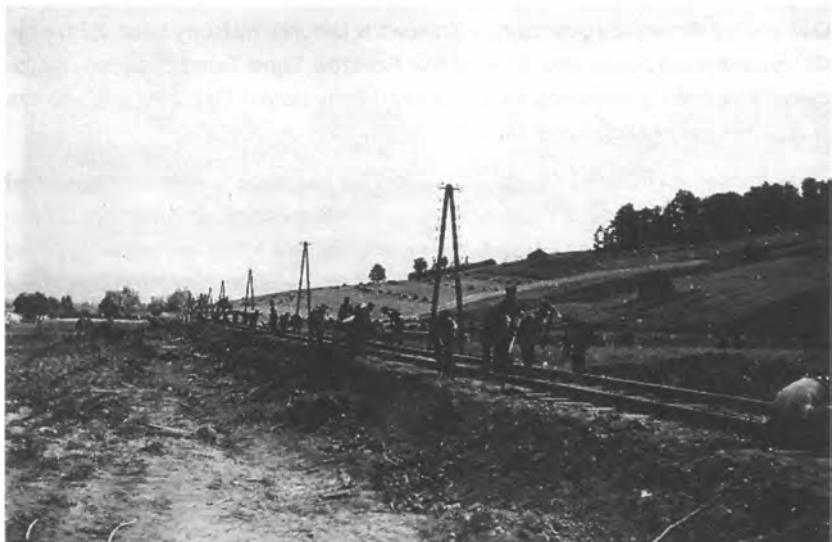
Lipiec 1934 r. Marcinkowice, km 69.0 – widok spod domku dróżnika w kierunku Nowego Sącza. Odbudowa toru kolejowego na linii Nowy Sącz–Chabówka. Fot. ze zbioru Ryszarda Krzeszowskiego
