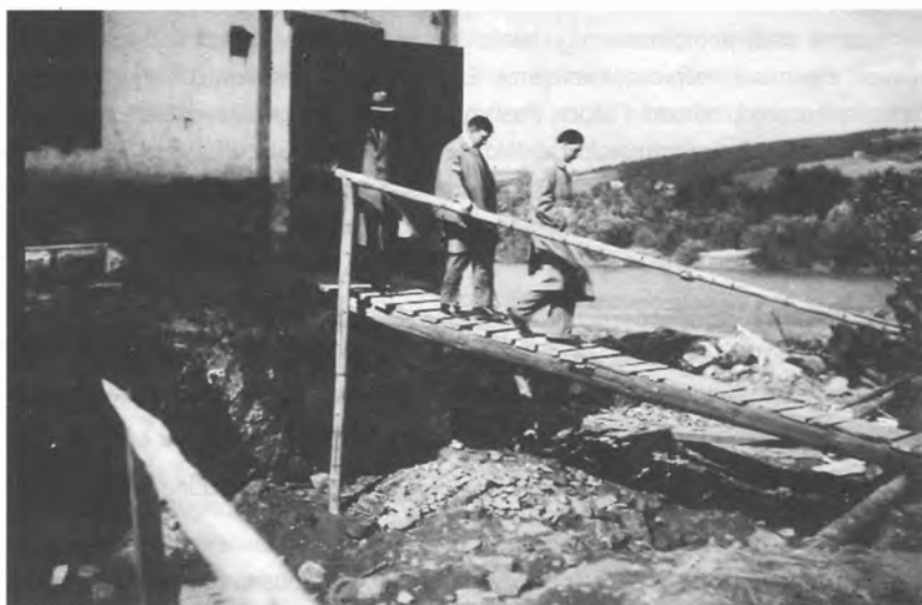
Lipiec 1934 r. Komisja opuszcza zniszczony domek dróżnika w km 69.0 linii kolejowej Nowy Sącz–Chabówka. Fot. ze zbioru Ryszarda Krzeszowskiego
