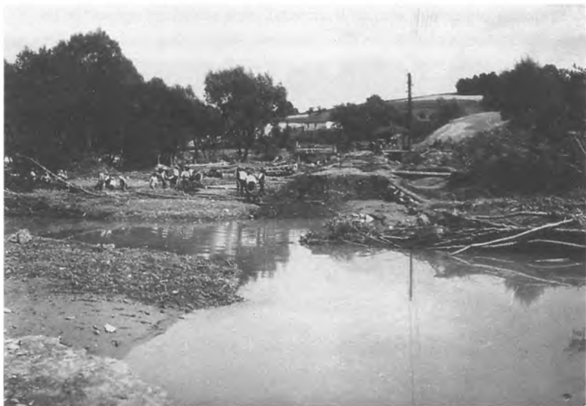
Lipiec 1934 r. Na linii Nowy Sącz–Chabówka. Woda zabrała nasyp, zniknęły też tory. Fot. ze zbioru Ryszarda Krzeszowskiego
