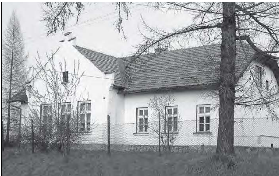
Budynek tzw. Starej Szkoły, stan z 2005 r.
