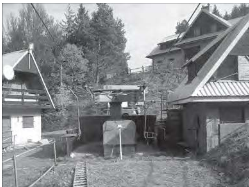
Wyciąg narciarski „Mostostal-1000” w Krynicy – Słotwinach podczas remontu
