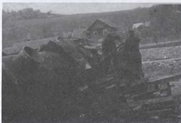
Podnoszenie wykolejonego parowozu
