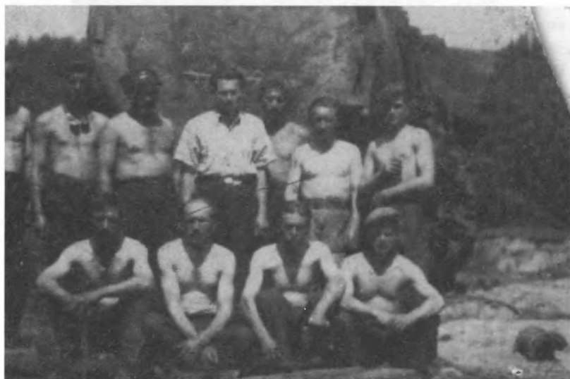
Usuwanie zniszczonych parowozów w Piwnicznej. Na dolnym zdjęciu pozuje brygada z parowozowni w Nowym Sączu wykonująca to zadanie. Lato 1945
