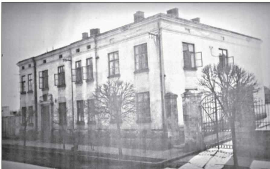
Budynek szkolny przy ul. Morawskiego
