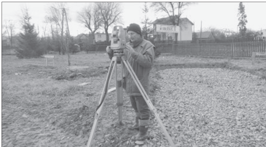
Wytyczenie terenu pod budowę hospicjum przez Jerzego Wituszyńskiego
