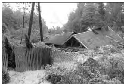
Zniszczony dom przy ul. Kamiennej Fot. Jerzy Cebula
