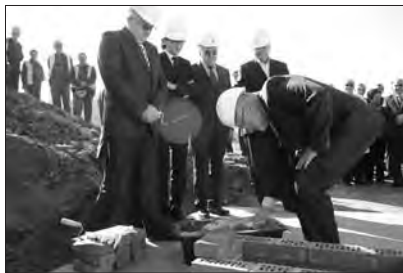
Rozpoczęcie budowy Miasteczka Multimedialnego
