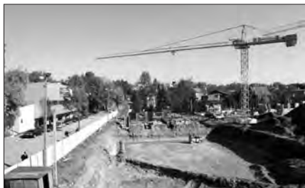
Budowa Instytutu Kultury Fizycznej PWSZ
