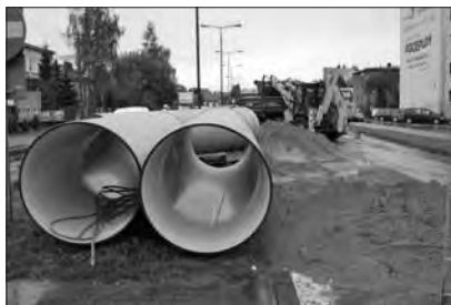
Modernizacja ul. Królowej Jadwigi
