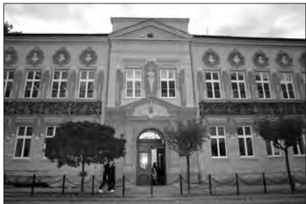
Szkoła im. Mickiewicza po remoncie
