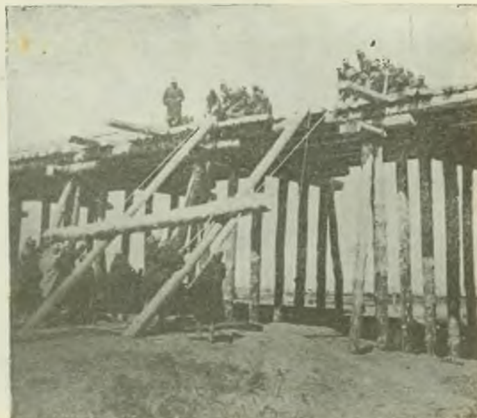
Wciąganie ciężkich belek przy budowie mostu na Dmestrze.
