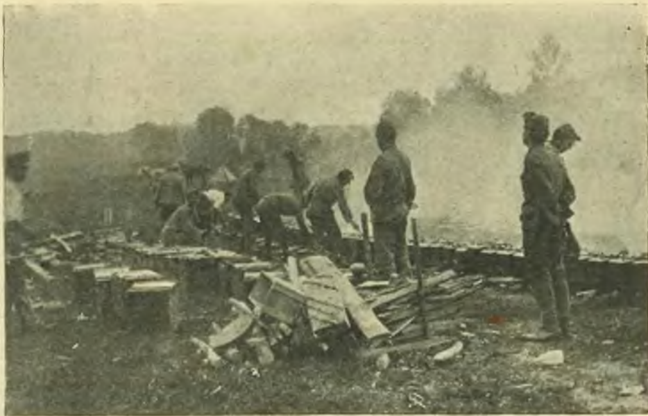
Zbudowany przez Rosyan szpital wojskowy przy ich odwrocie z pod Sokala zupełnie zburzony.
