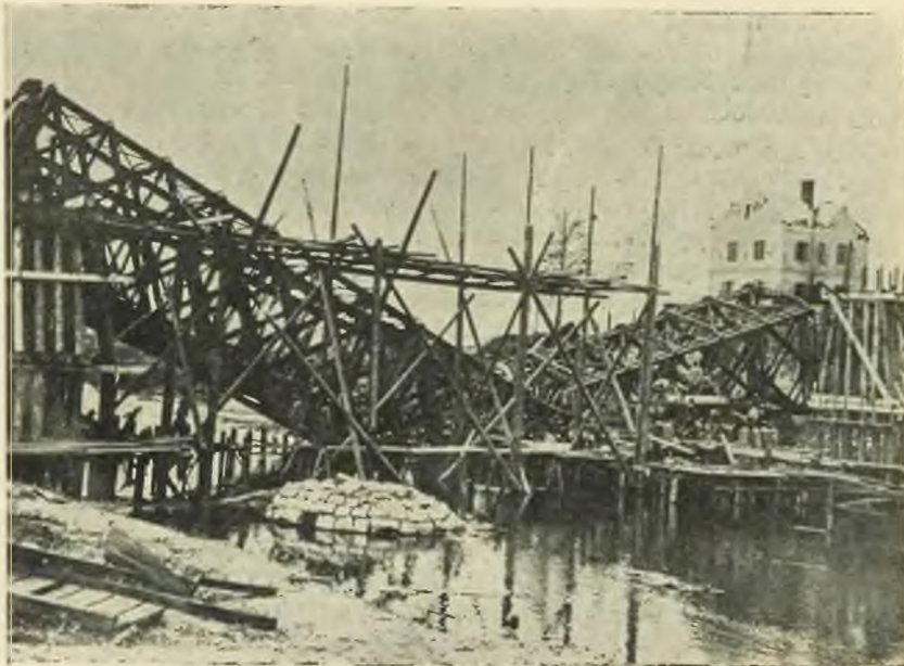
Zburzony przez Moskali most koło Rzerzowa. — Obok rozpoczęta budowa przez naszych pionierów prowizorycznego mostu.
