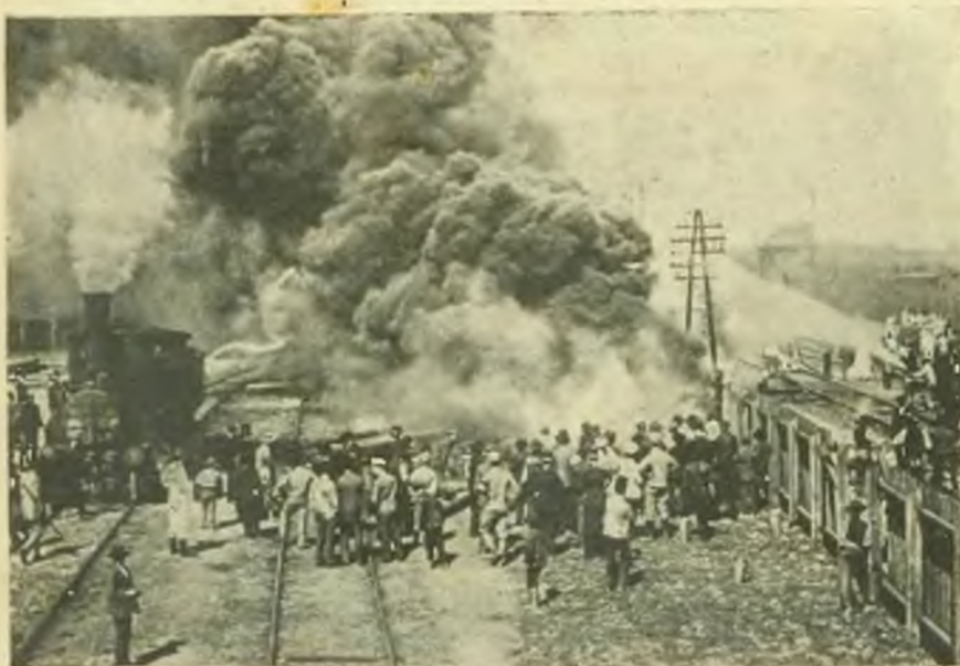
Pożar na dworcu w Debreczynie.
