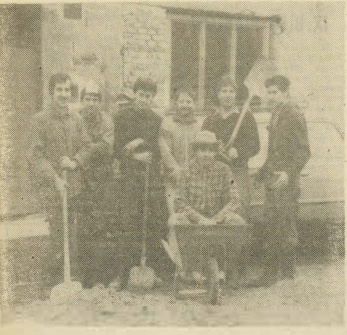
Członkowie kola ZMW przy budowie Klubu Rolnika w Bobowej.
