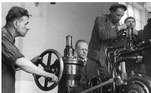
Ryc.11. Elektrownia przy Łazienkach Borowinowych. Człon regulacyjny turbiny parowej firmy Pierwsza Brneńska Fabryka Maszyn. 1947r. Fot. H. Hermanowicz. Fot. ze zb. prywatnych L. Walczyka.
