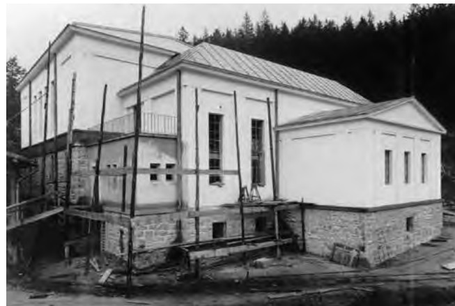
Ryc.5. Budynek dolnej elektrowni. Budynek nadal istnieje. Fot. ze zb. prywatnych L. Walczyka.
