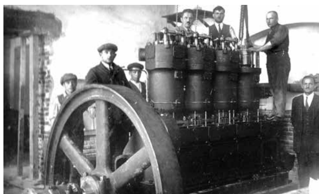
Ryc.2. Elektrownia przy Nowych Łazienkach Mineralnych. Montaż silnika wysokoprężnego napędzającego generator prądu o mocy 92 kW. Fot. ze zb. prywatnych L. Walczyka.
