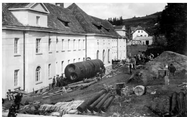
Ryc.1. Nowe Łazienki Mineralne. Budowa elektrowni. Fot. ze zb. prywatnych L. Walczyka.
