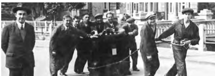
12. Transport transformatora pomiędzy elektrowniami. Fot. ze zb. prywatnych L. Walczyka.
