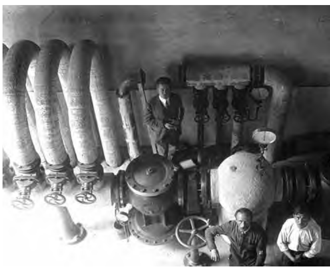
Ryc.4. Nowe Łazienki Mineralne. Rozdzielacz pary na kotłach (25 VII 1927r.) Fot. ze zb. prywatnych L. Walczyka.
