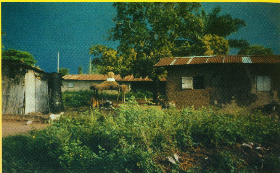
Kiedy wchodzi się do wioski można zauważyć domy zbudowane z gliny lub cegły, pokryte słomą lub blachą.
