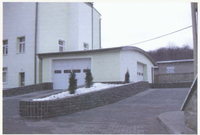
W bieżącym roku w krynickim szpitalu przeprowadzono szereg remontów i modernizacji. Najbardziej widoczna jest nowa elewacja i podjazd dla karettek.
