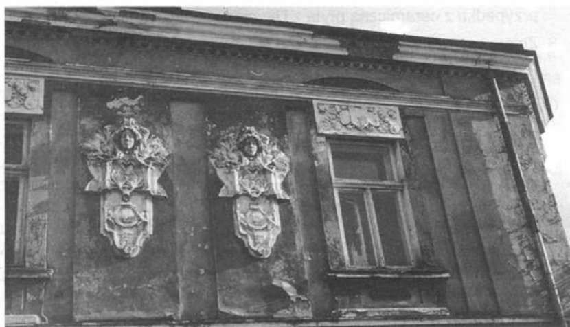
Detal z elewacji kamienicy narożnej w Grybowie. Fot. J. Samek 1998 r.
