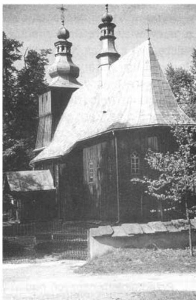
Kościół pw. Narodzenia NMP w Krużłowej z 1520 r., odnawiany w latach 1785, 1894, 1932. Fot. J. Samek 1997 r.
