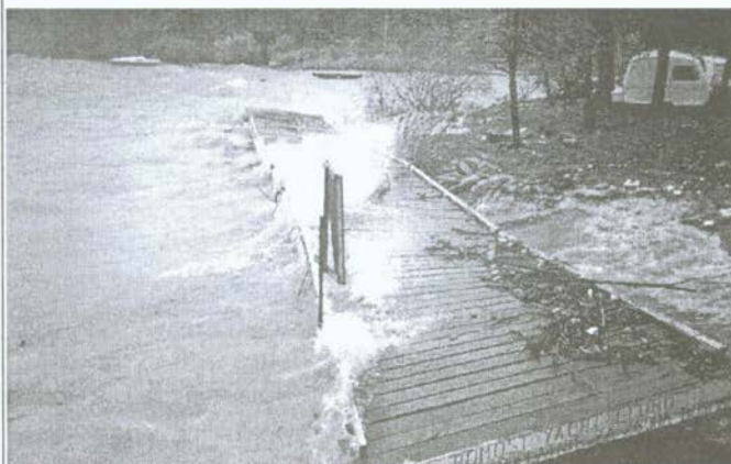
Październik 98 zerwany i uszkodzony pomost
