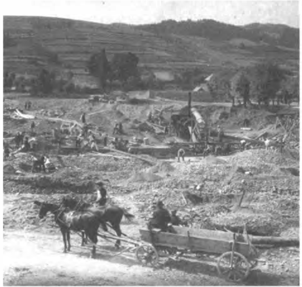
Budowa przyczółków mostu w Powroźniku na rzece Muszynka. Rok 1910
