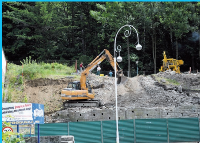
Trwają prace remontowo-budowlane przy wejściu do parku od ul. Ebersa.
