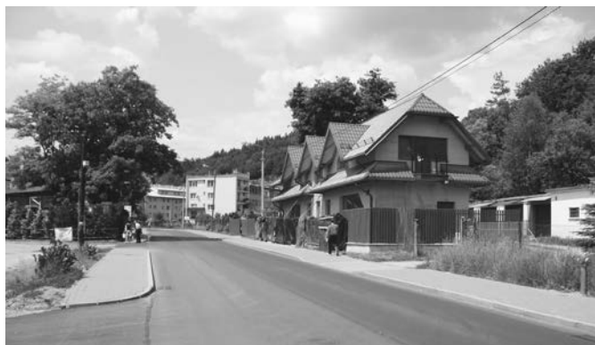
Nowa nawierzchnia asfaltowa na osiedlu Czarny Potok.
