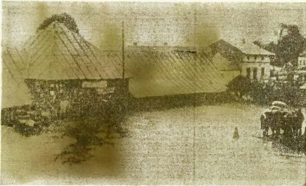
Miejska targowica pod wodą
