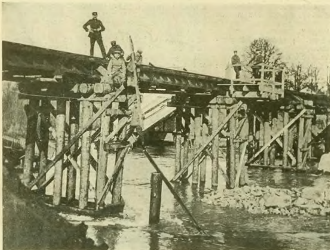
Zburzony i na nowo naprawiony most koło Reimów na torze Sedan—Reims.
