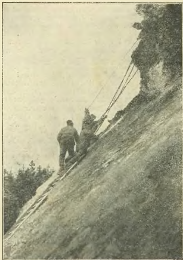
Uciążliwa praca żołnierzy przy budowie dróg wojskowych w Szwajcaryi.
