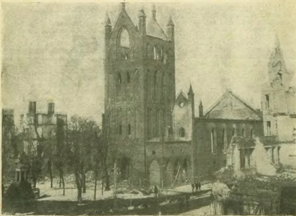
Zniszczony kościół w Elku (Prusy wschodnie).
