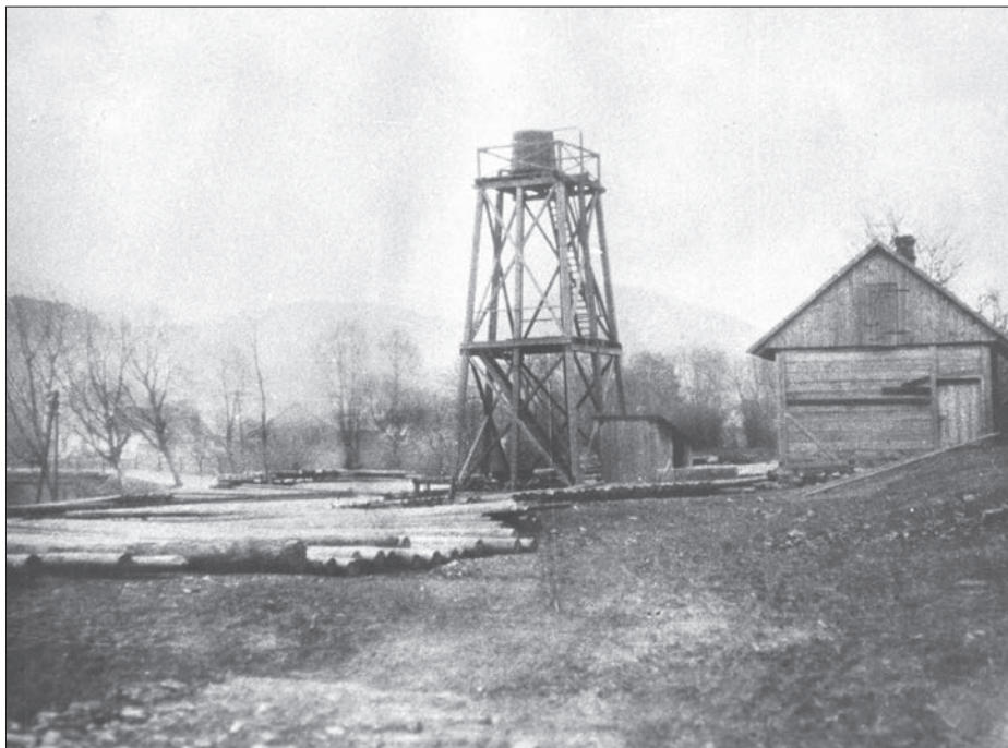
Zakład impregnacyjny w Łabowej, 1928 r.
