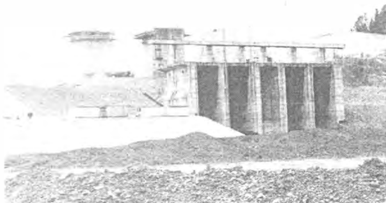
Czorsztyńska zaporę w trakcie budowy. Widok od północy Fot. Archiwum
