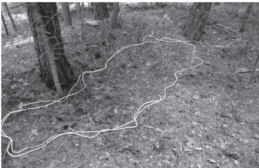
Fragment linii umocnień rosyjskich (okop i dołek strzelecki) znajdujących się na wschodnim brzegu Kamienicy, obecna głębokość około 15 – 30 cm (dla większej czytelności linia okopu zaznaczona liną)
