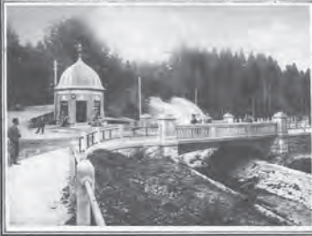
Z „nowej” Krynicy: nowy most na drodze od dworca kolejowego do Damskiego Zdroju. Fot. M. Misa, Lwów.
