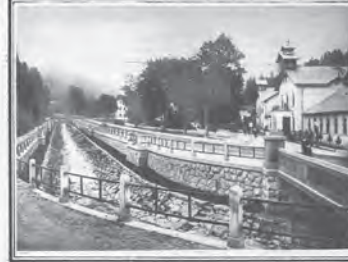
Z „nowej” Krynicy: na prawo nowa latarnia gazowa, na lewo w głębi nowy budynek Damskiego Zdroju. Fot. M. Misa, Lwów.
