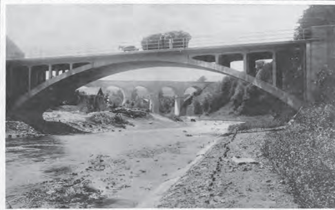
Nowy most w Grybowie. Na rzece Białej w Grybowie stanął wspaniały most łukowy z żelazo-betonu, o rozpiętości 36 m. w świetle, wybudowany przez Krak. Okręgową Dyрекcyję Robot Publicznych we własnym zarządzie. Budowę pięknego mostu, który reprodukujemy, kierował inż. Franciszek Milan. Fot. statum. Grybow.
