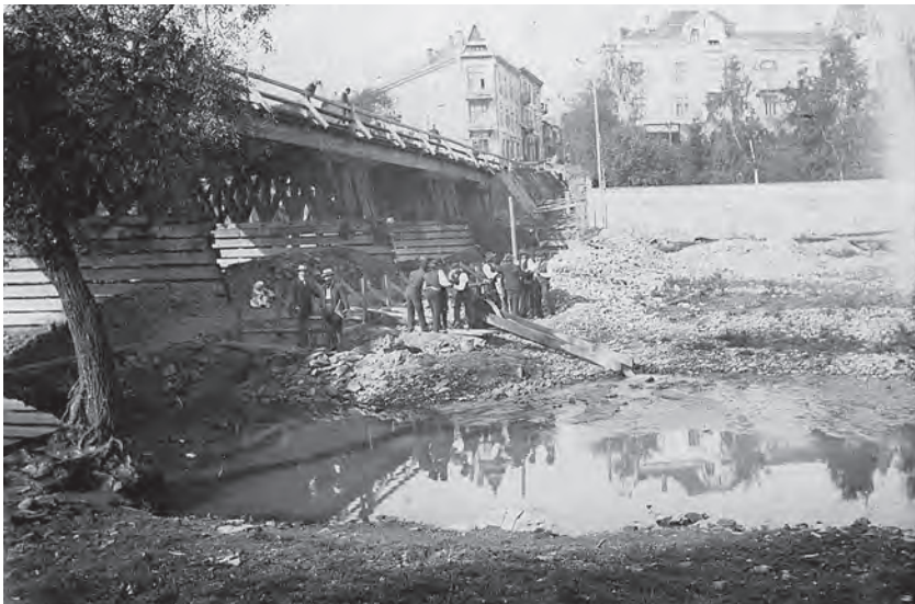
Budowa syfonu pod rzeką Kamienicą, 1912 r. (archiwum rodzinne)
